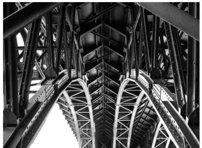
Die Fachwerkbögen des Chemnitzer Viaduktes verfügen über eine ausreichende Restlebensdauer [4]
